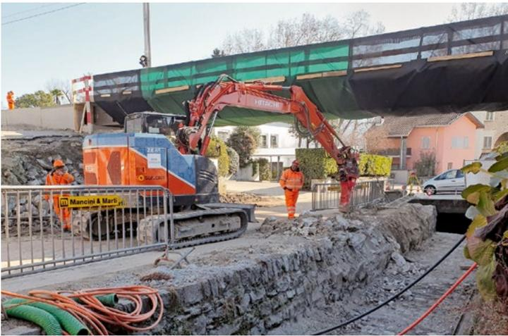
**Auch Arbeiten mit dem Hydraulikhammer sind für den E-Bagger kein Problem.**
